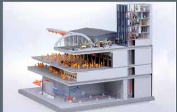
**VERSTECKTE POTENTIALE** gilt es zu nutzen: Die Körperwärme der Menschen, die täglich durch den Bahnhof in Stockholm gehen, wird auf den Heizwasserkreislauf eines angrenzenden Bürogebäudes übertragen.
