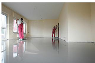
Spiegelglatte Oberflächen zeigen alle Spachtelmassen von Thomsit, die auf Basis der Ultraglatt-Technologie aufgesetzt sind (Thomsit 16).
