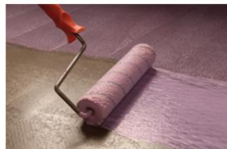
Die Fixierung kann stehend mit einer Nylon-Plüschrulle auf den Boden aufgetragen werden (Thomsit 14a,b).
