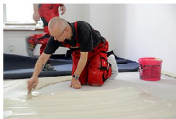
Durch die glatte Oberfläche der Spachtelmasse aus der Ultraglatt-Technologie-Linie von Thomsit können bis zu 15 Prozent Klebstoff eingespart werden (Thomsit 02a,b).
