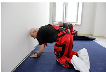
Nachdem der Untergrund vorbereitet war, maßen die Mitarbeiter der Fußboden-Fachfirma Schauf die zu verlegenden textilen Beläge aus und schnitten die Teilstücke zu (Thomsit 01).
