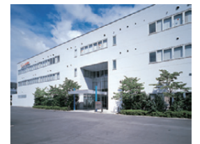
横浜/ アジアパシフィック技術センター
