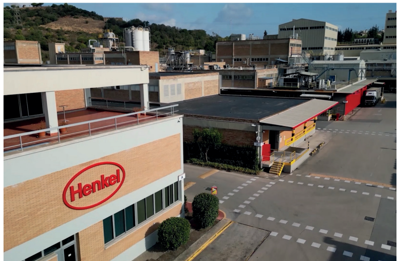
Ilustración 14. Centro productivo de Henkel en Montornès del Vallès (Barcelona).
