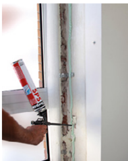
Teroson SPS Schaumklebstoff in der Anwendung (Teroson 08).
