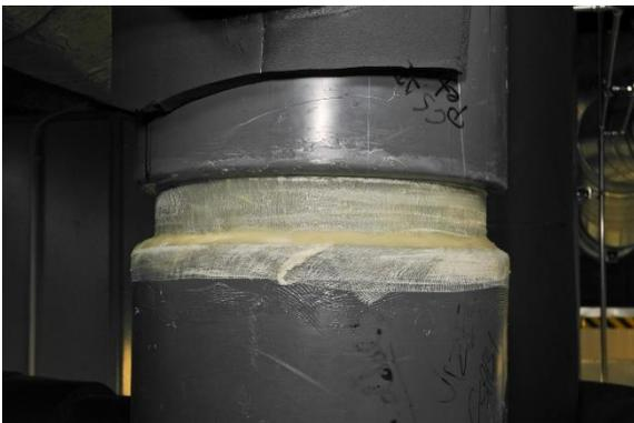
Im steten Wechsel von Klebstoffauftrag und darin eingebetteten Mullbinden-Wicklungen wurde der gesamte Bereich um die Leckage überarbeitet.
