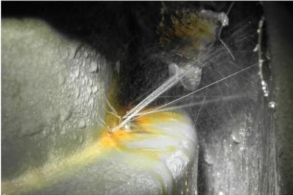
In der Forschungseinrichtung war eine der zentralen Steigleitungen im Kühlwasserkreislauf an einer Muffe DN250 leckgeschlagen.
